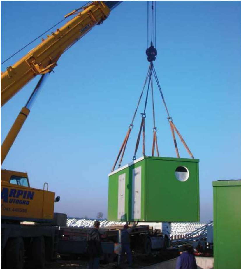
posa in opera di un monoblocco
