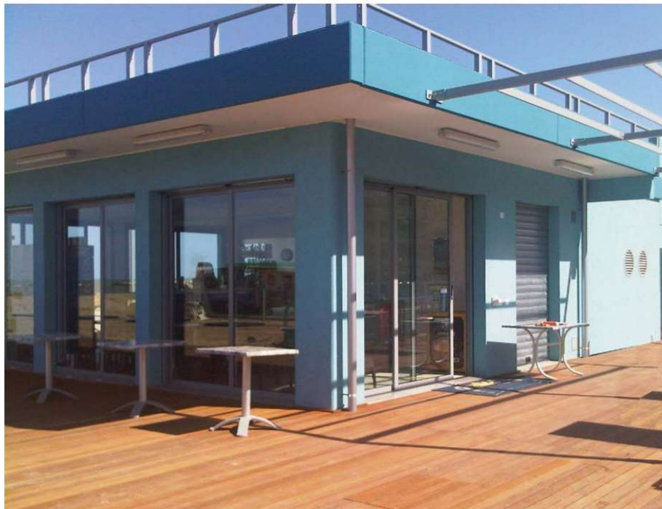
Valverde (FC) - Bagno Giorgio pareti portanti pfrefabbricate
