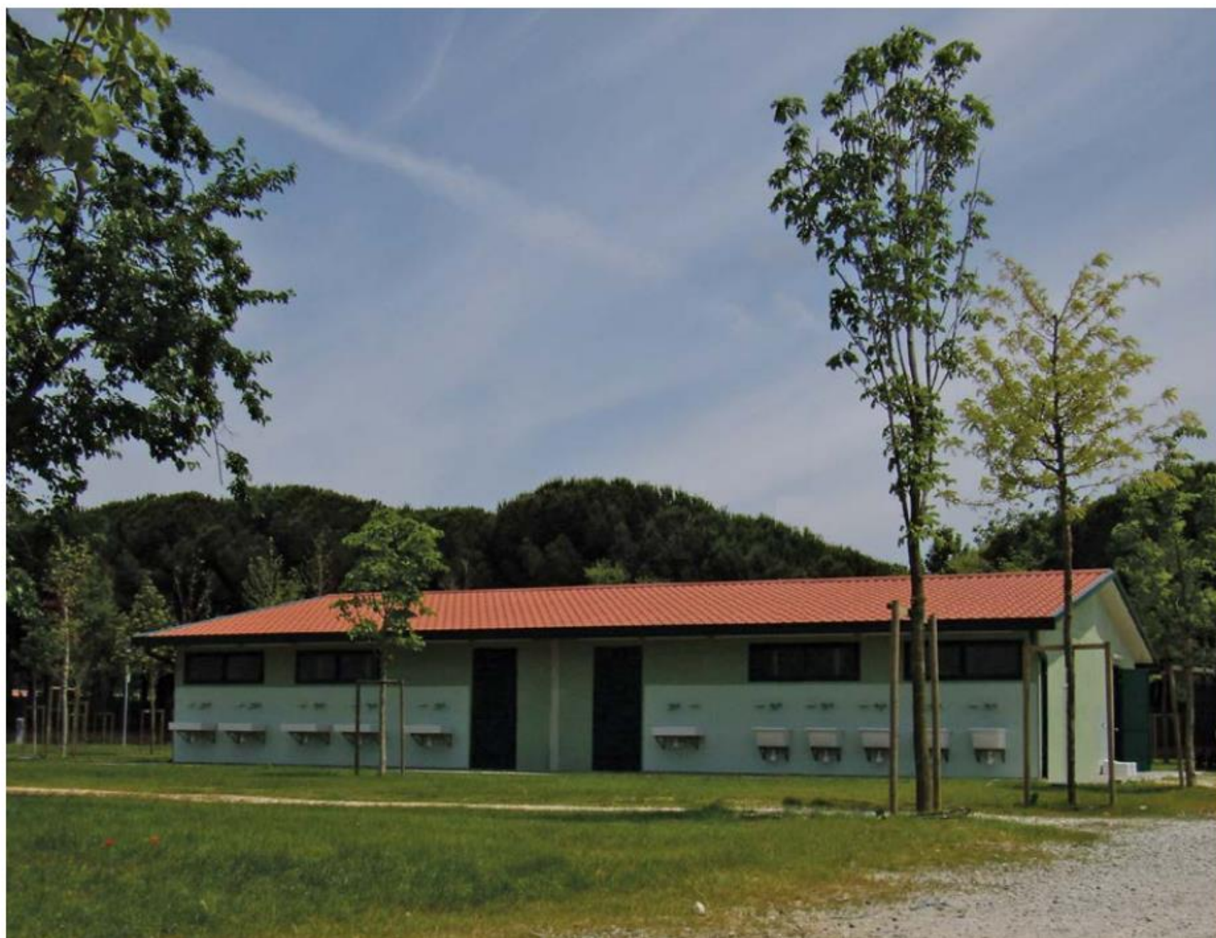
Cesenatico (FC) | Camping Gesturist | pareti portanti prefabbricate
