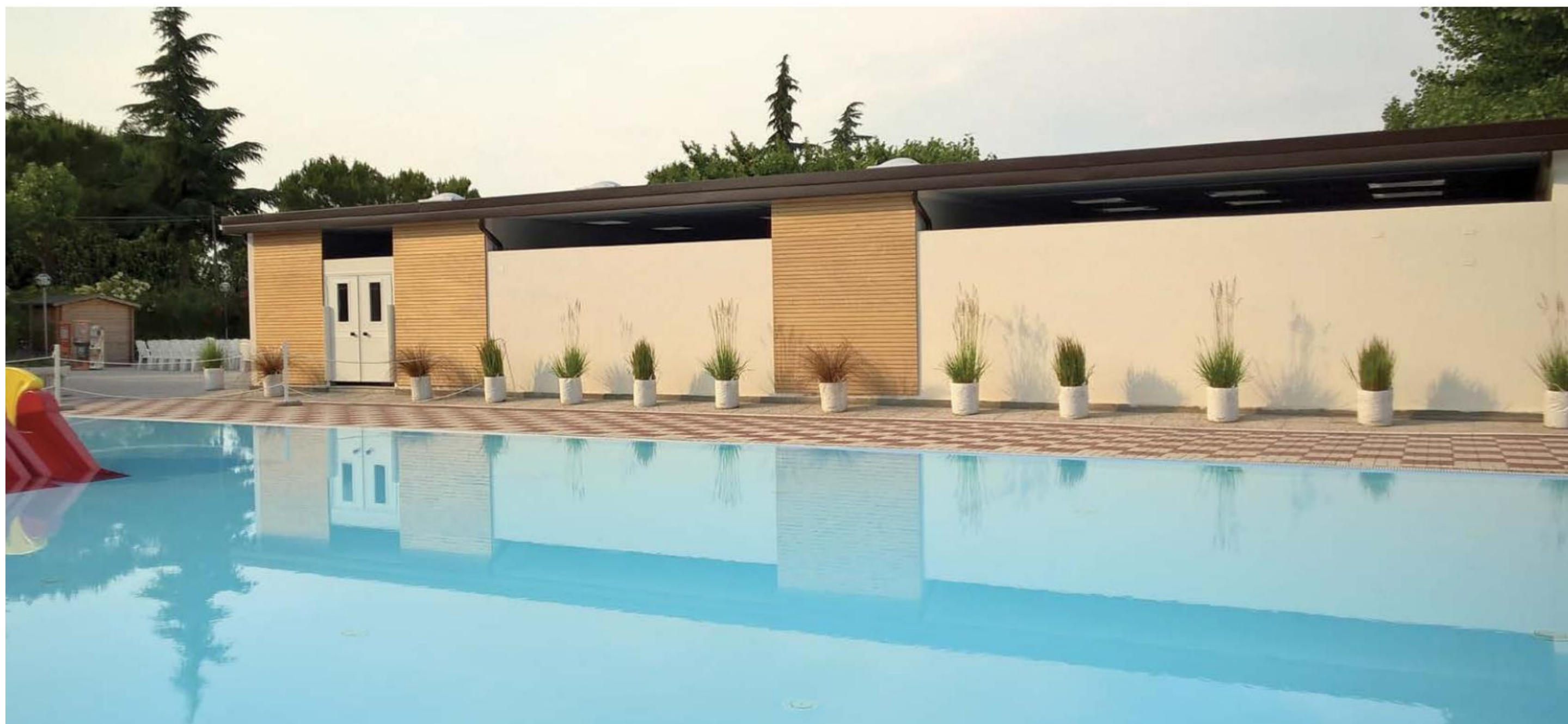
Peschiera del Garda (VR) | Camping San Benedetto | pareti portanti prefabbricate
