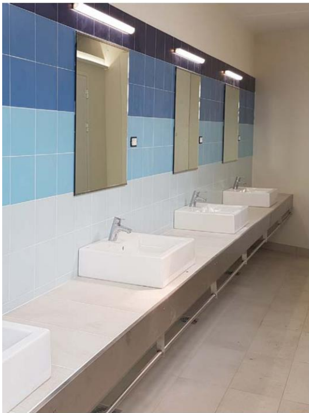
Pinarella di Cervia (RA) | Camping Adriatico | struttura pareti portanti prefabbricate
